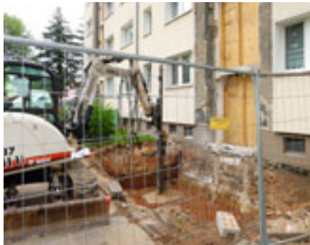
Etappen des Fahrstuhlbaus in der Schulstraße 11
